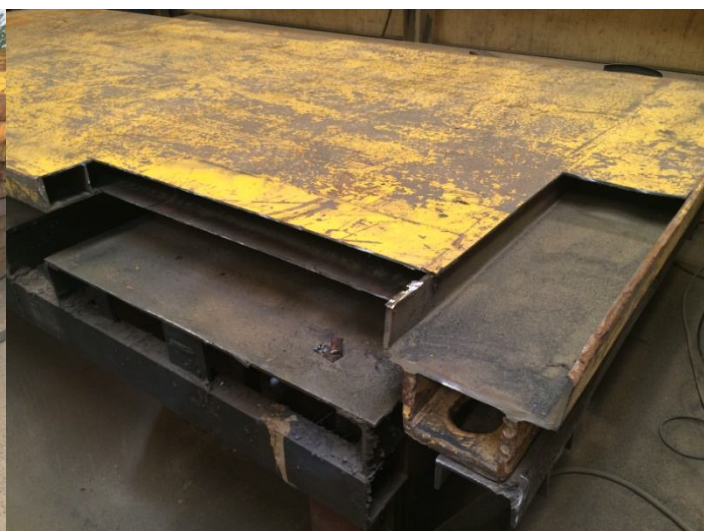
Płyta w trakcie remontu
