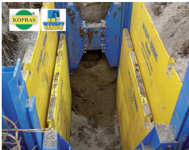
Fot. 5 Montaż płyt wewnętrznych i pogłębianie wykopu
