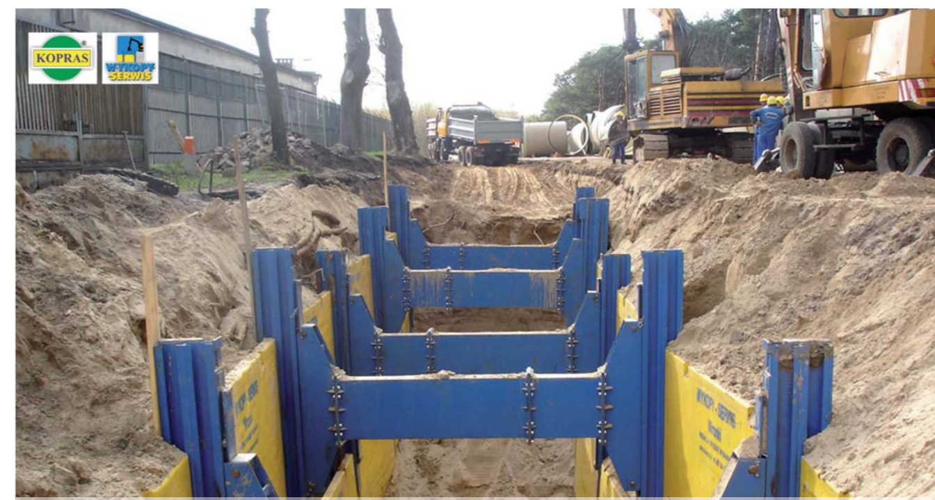
Fot. 4. Liniowa obudowa wykopu do głębokości 4,8 m z rozporą rolkową
