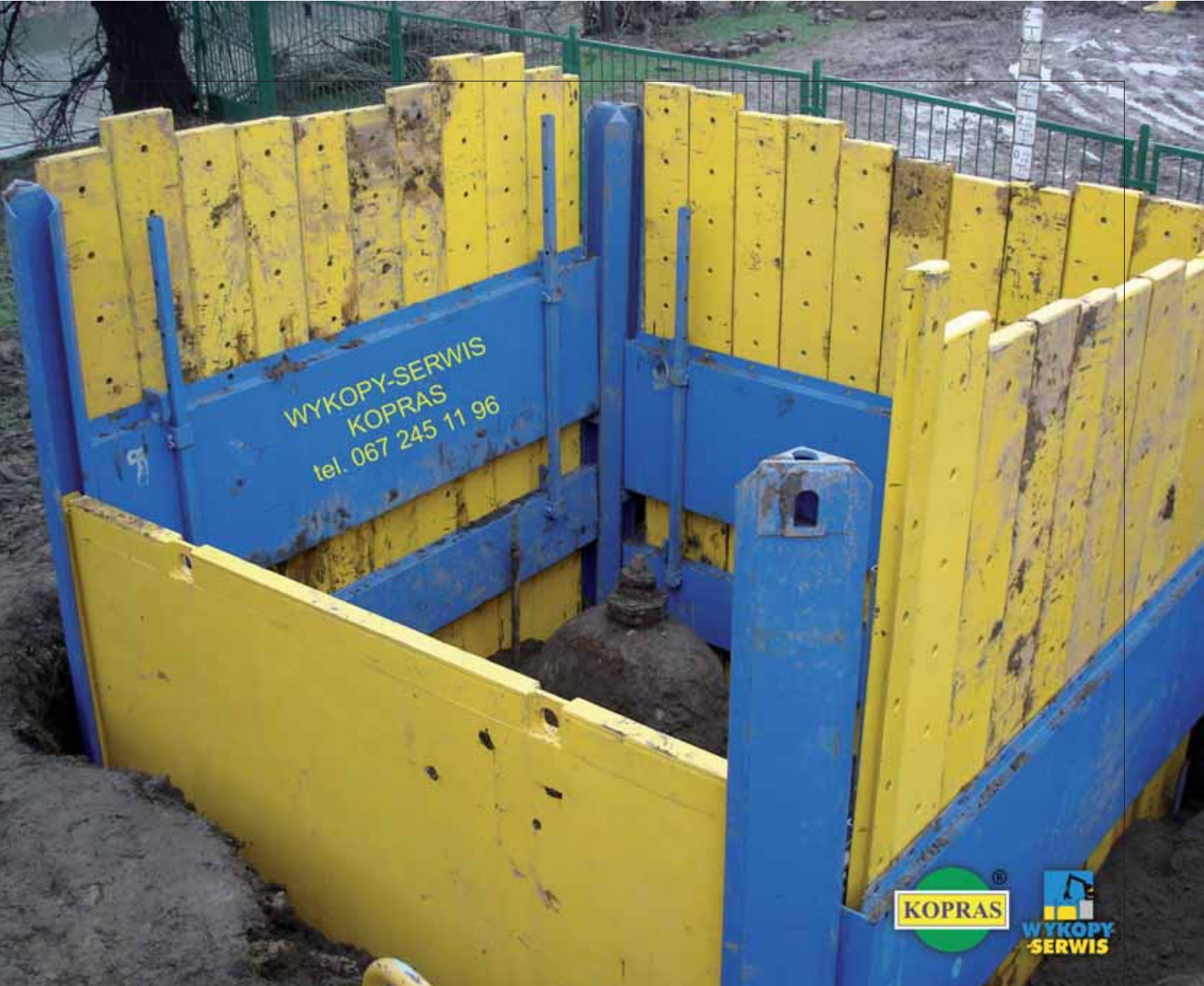
Fot. 3. Szalunki słupowe
