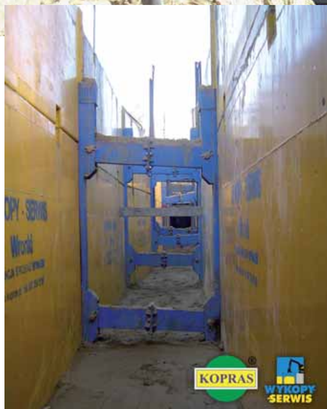
Fot. 2. Liniowa obudowa wykopów
