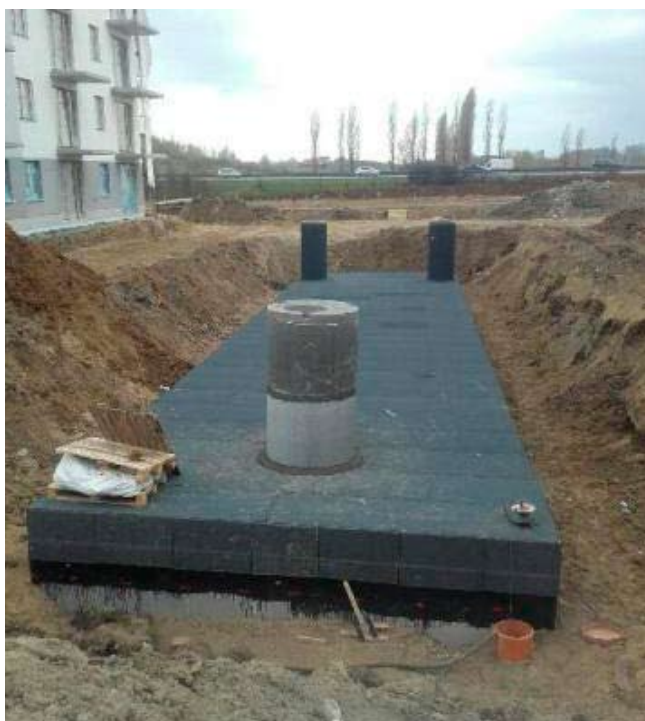
Rys. 13. Efekt końcowy realizacji zbiornika retencyjnego
