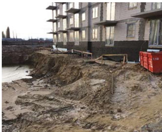
Rys. 4. Widok placu budowy przed zgłoszeniem się do firmy Kopras
