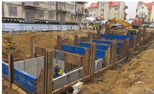
Rys. 10. Fragment montażu elementów prefabrykowanych zbiornika
