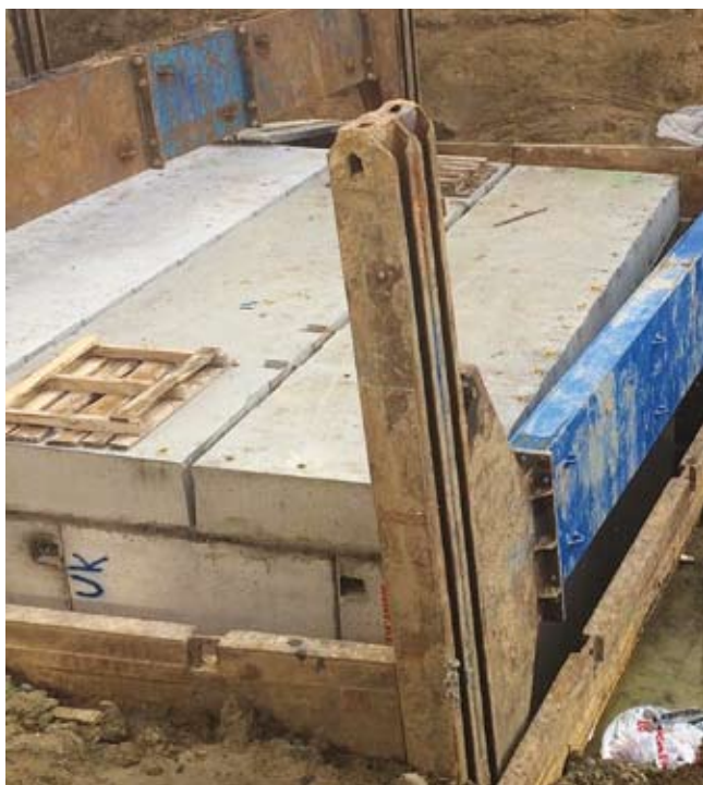
Rys. 12. Fragment montażu płyt przekrywających zbiornik
