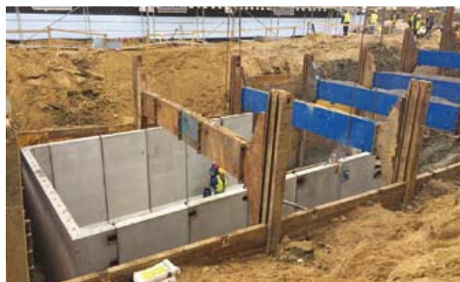
Rys. 10 i 11. Ogólny widok przedstawiający budowę zbiornika retencyjnego z wykorzystaniem elementów prefabrykowanych przy zabezpieczeniu wykopu obudową firmy Koproas
